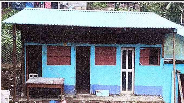
Foto 2: vista Frontal del módulo ya finalizando el trabajo, con la colocación de láminas, cambio de costaneras y la altura de la misma.
