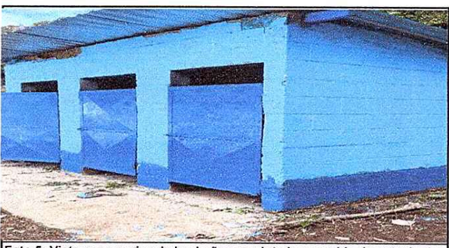
Foto 5: Vista panorámica de los baños ya pintada y cambio de entechado.
