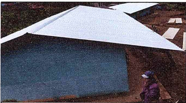
Foto 3: Vista panorámica del módulo ya instaladas las láminas.
