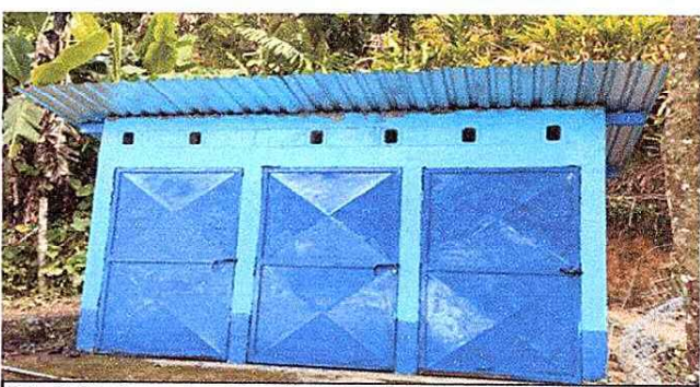
Foto 6: Se observa la colocación y cambio de láminas de los baños de la escuela ya con su acabado.
