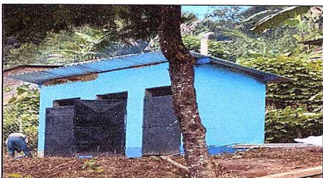
Foto 4: Vista del acabado de los baños de mejoras y cambio de entechados.
