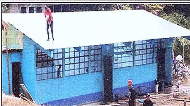
Foto 1: Se observa el mantenimiento y cambio de entechado de este módulo.
